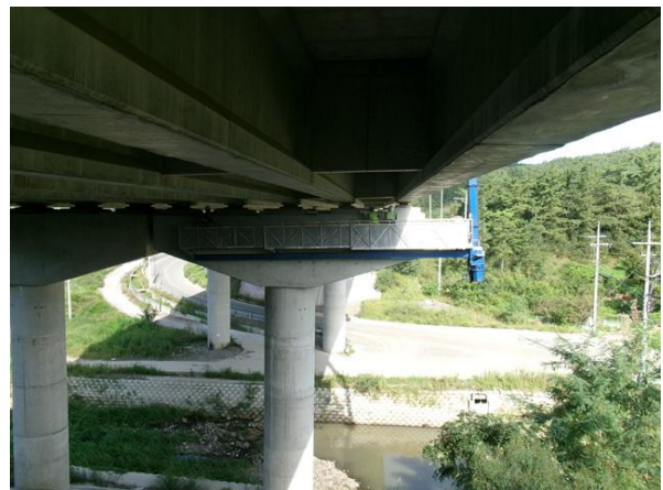
굴절점검차를 이용한 근접조사
