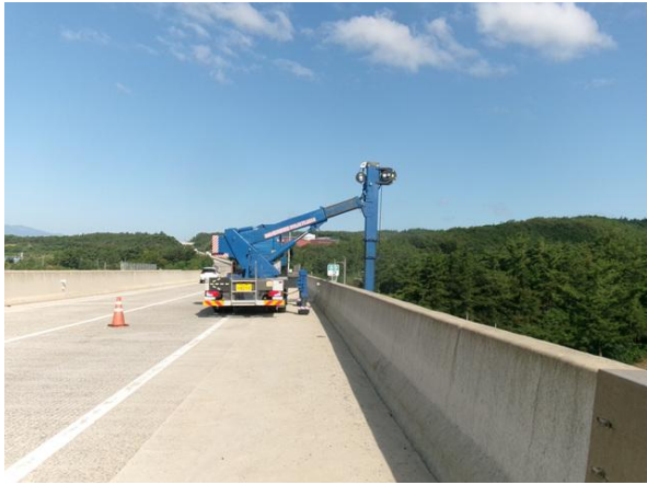
굴절점검차를 이용한 근접조사
