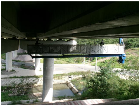
굴절점검차를 이용한 근접조사
